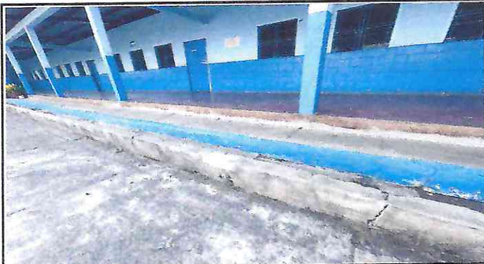
Foto 3. Remozamiento de gradas de patio en mal estado
